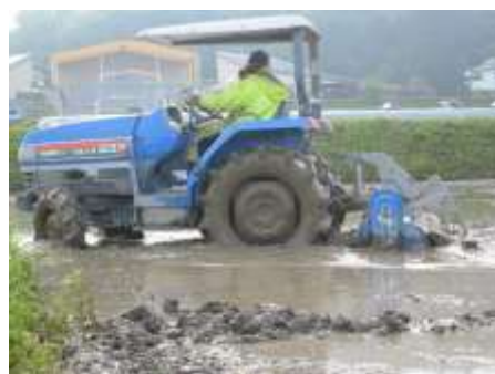
Photo- 6 この水田土を有効利用して施工
