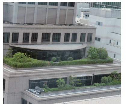
大阪市 武田薬品本社ビル屋上緑化 (1991 年竣工)
